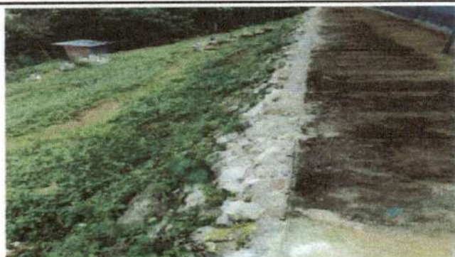
Foto 3: Reparaciones de muro.
