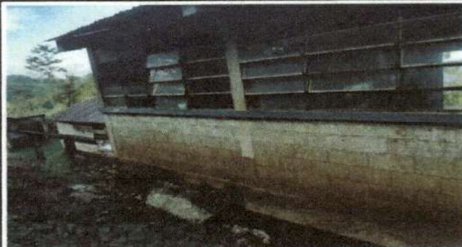
Foto 4: reparacion de pasillo del modulo I
