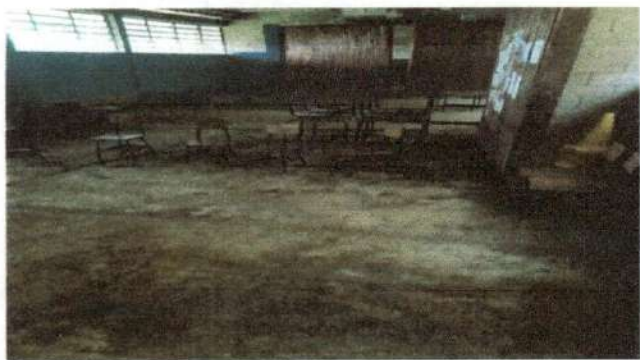
Foto 1: Se observa el deterioro del piso de torta
