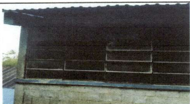
Foto 5: Se observa el deterioro de los vidios y la necesidad de sustituirlos
